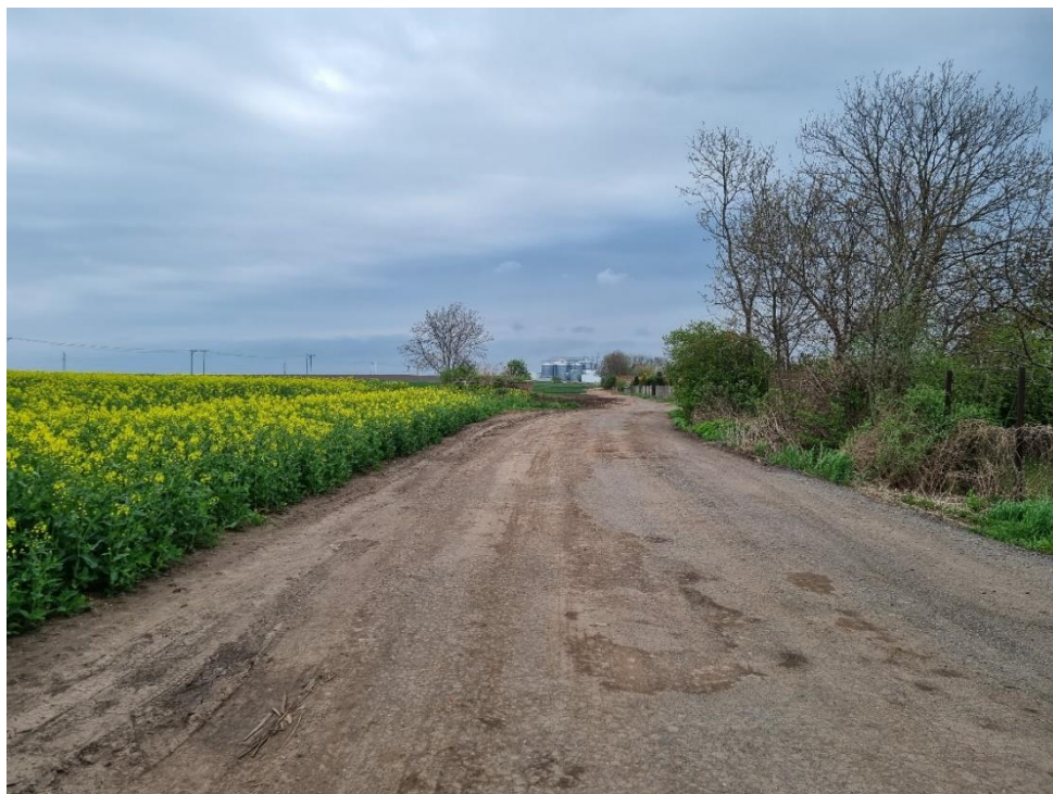
Rys. 16. Widok drogi dojazdowej do pól, z której pobrano próbki nawierzchni do badań.
