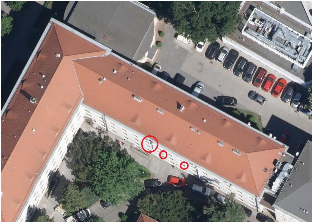
Zdj. 1 Widok dachu
